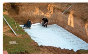
< 04 > Mise en place du géo-textile
