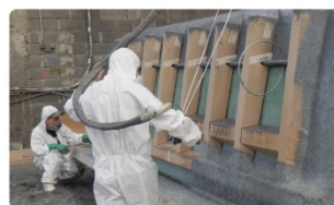
< 09 > Projection Simultanée Fil de verre + résine Ortho
