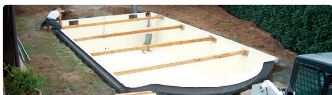
< 08 > Installation de la coque dans son trou
