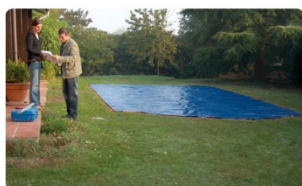
< 01 > Préparation de l'emplacement
