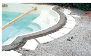
< 09 > Installation des margelles
