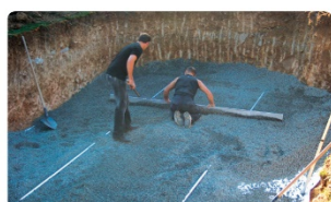
< 06 > Mise à niveau du fond
