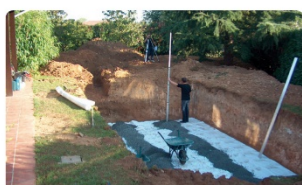
< 05 > Remblaiement de graviers
